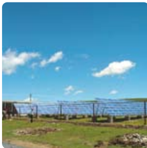
Pequeña central eléctrica
