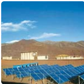
Pequeña central eléctrica
