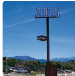
Iluminación de carreteras
